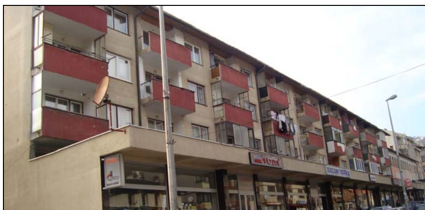
Slika 33. Višestambeni objekt u užoj urbanoj zoni
