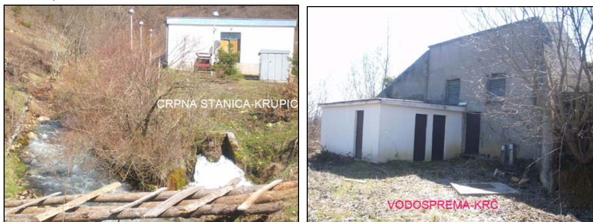
Slike 50. i 51. – crpna stanica „Krupić“ i vodosprema „Krča“
